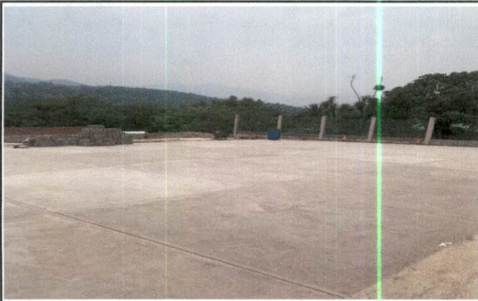
Foto 1: MEJORAMIENTO DE LOSA DE PATIO
