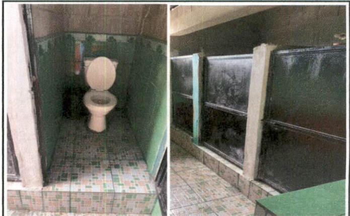
Foto 2: MEJORAMIENTO DE SERVICIOS SANITARIOS Y SUS ACCESORIOS
