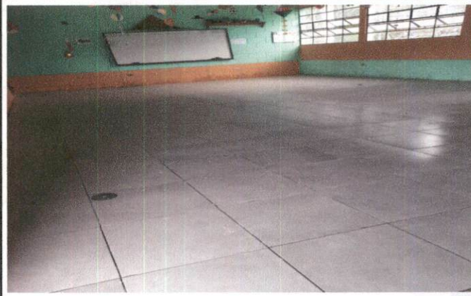
Foto 2: MEJORAMIENTO DE PISO
