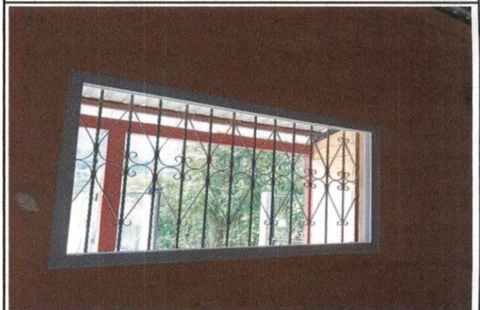
Foto 4: MEJORAMIENTO DE VENTANAS
